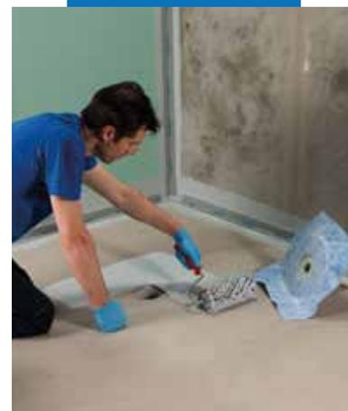
Установка **Drain Vertical**, используя **Mapegum WPS**
