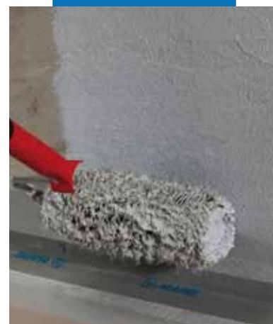
Нанесение **Mapegum WPS** с помощью валика
